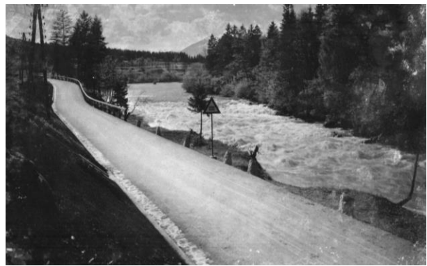
Gesäuseeingang ohne Baumbestand, um 1945.
