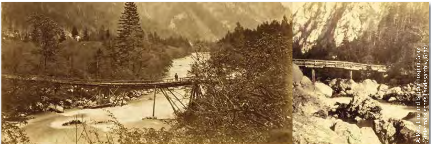
Zwei Varianten der Brücke über die Enns in der Nähe der Insel beim Gesäuseeingang. Früher ein neuralgischer Punkt der Durchquerung des Gesäuses und durch Hochwässer immer wieder zerstört. Im Bereich der Lettmairau führte eine zweite Brücke wieder zurück auf das rechte Ennsufer.
